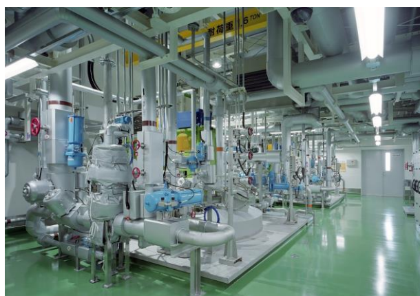
第二発酵棟内の新規発酵槽
