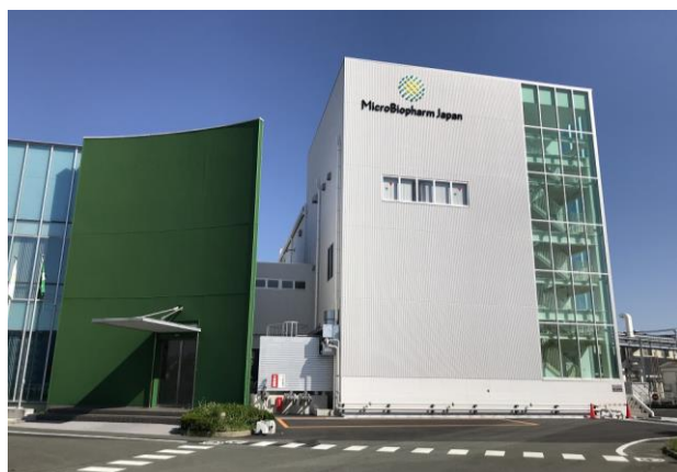
第二発酵棟外観
